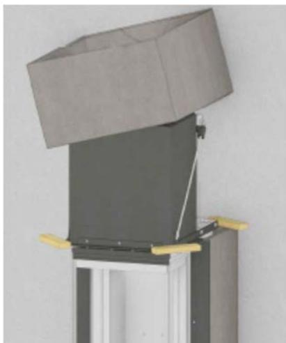
Das erste Hauben-Element (dieses hat nur eine kleine Ausbuchtung für den hinteren Rauchrohr-Anschluss) leicht schräg über den Kamineinsatz schieben und auf den hinteren Beton-Elementen aufsetzen. Diese ggf. mit Holzleisten schützen (Holzleisten natürlich wieder wegnehmen!).
